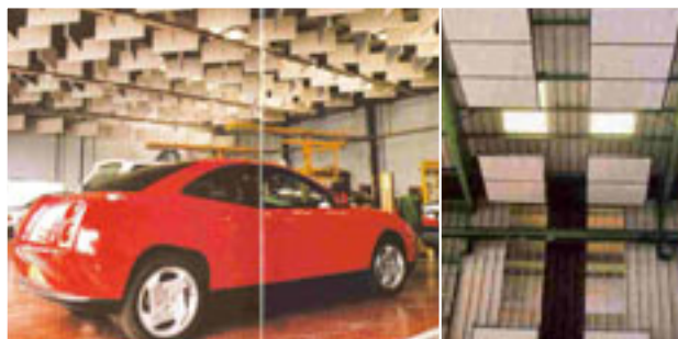
Figura 4.19 Garaj – Capacitatea de absorbție a încăperii (© Yves Cousson – Prin amabilitatea INRS – Franța)
