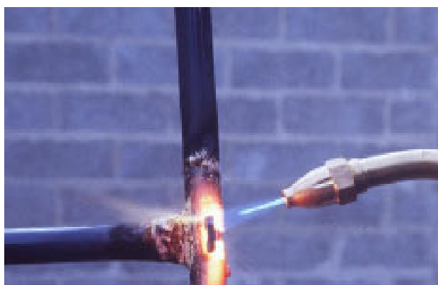
Figura 4.4 Construcții – Utilizarea unei lămpi de sudură silențioase (© Yves Cousson – Prin amabilitatea INRS – Franța)
